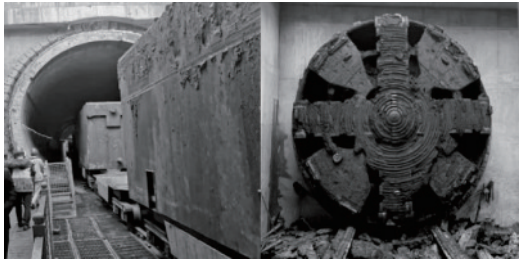
图9 盾构机进出洞现场图
